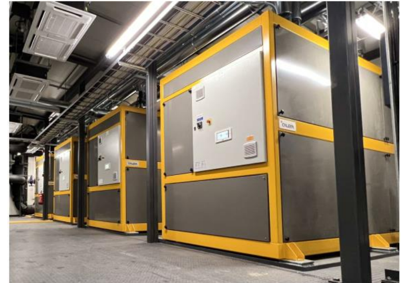
Esimerkkikuva AmbiHeat-lämpöpumppulaitoksen teknisestä toteutuksesta (Calefa)
